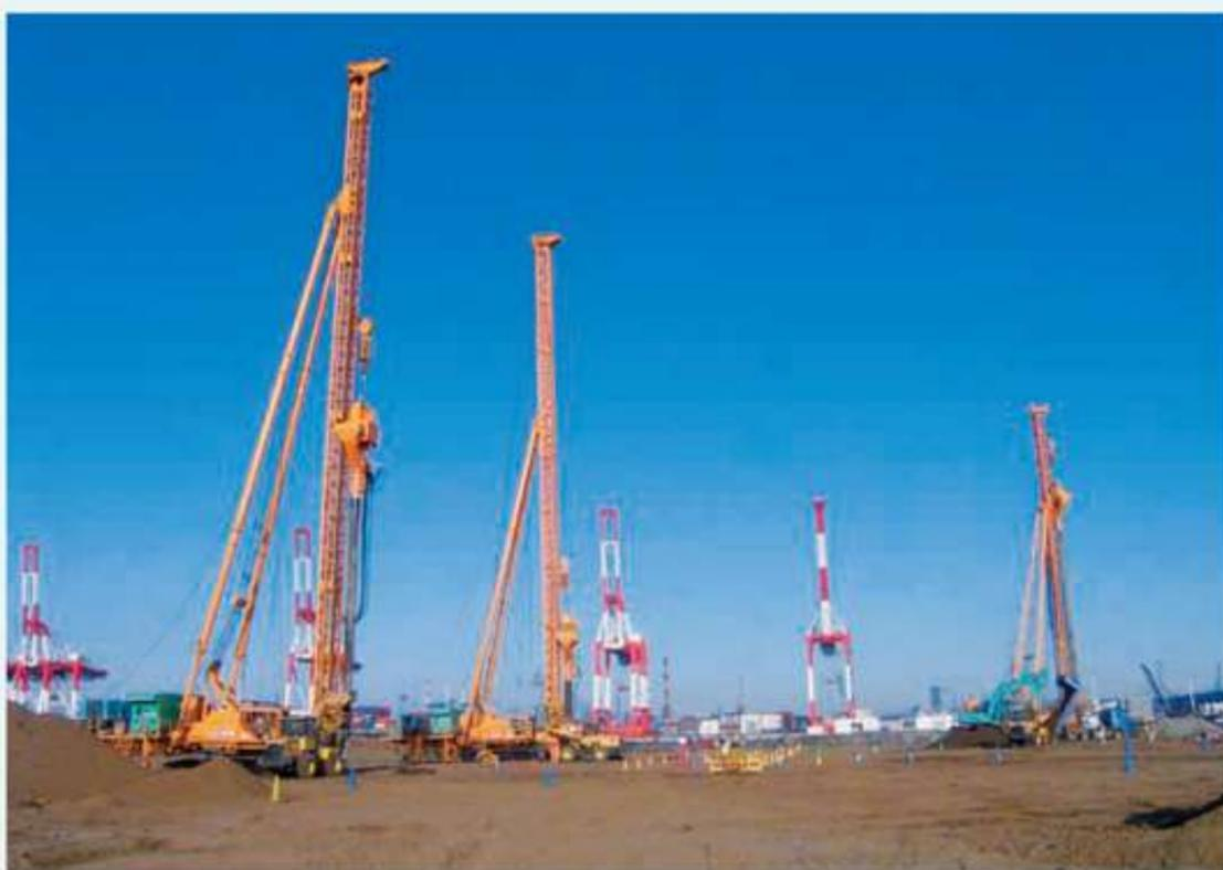
施工鑽機配置自動提昇時間控制器、經緯儀、迴轉定速器，配合超高壓幫浦與自動水泥拌合設備施工。
